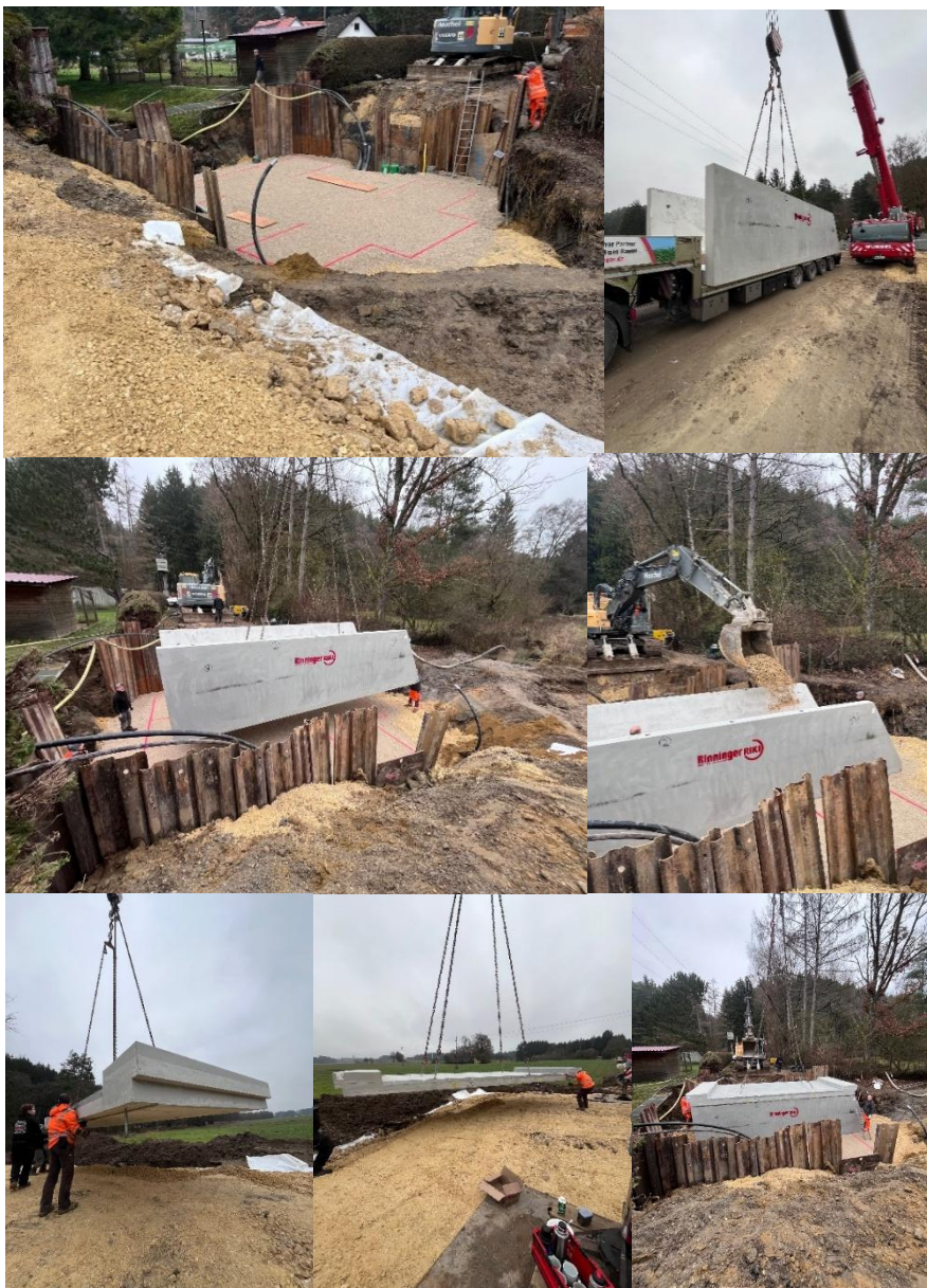
Bild: © Markus Bayer, Markt Biberbach, Bauamt
